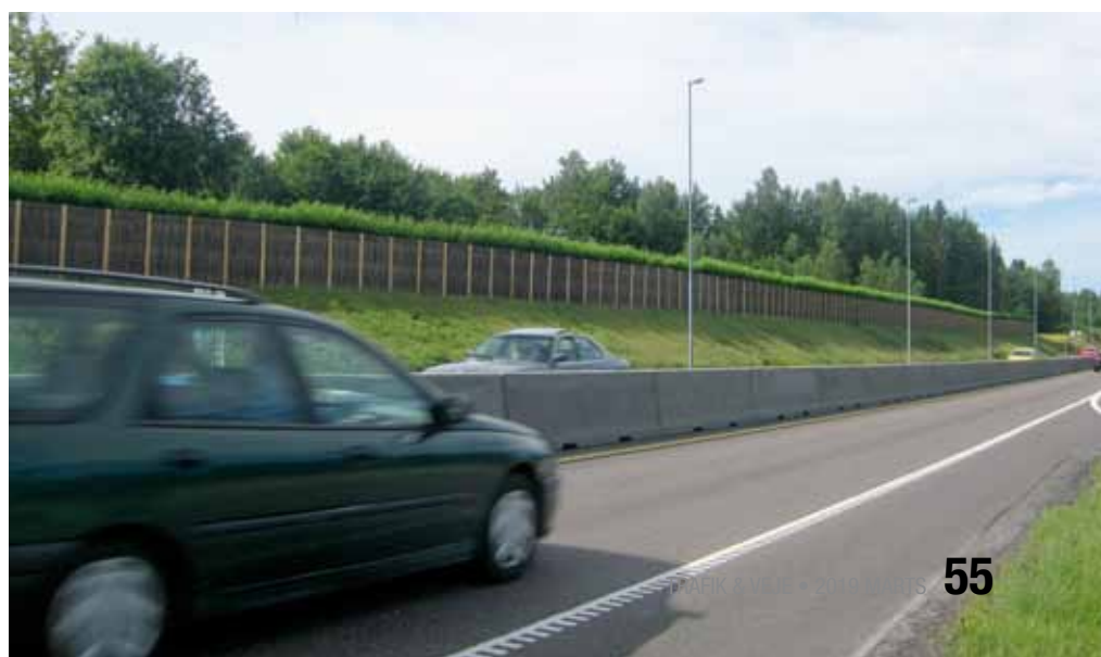
Figur 3. Naturskærm med en levende facade indbygget. De levende pilestammer sætter i vækståret en stor løvmasse, der optager CO 2 , alt imens støjskærmen dæmper støjen.
