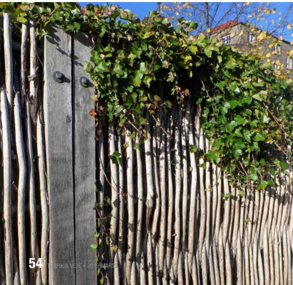
Figur 1. Naturskærm til dæmpning af støj, smukt patineret – uden vedligehold.
